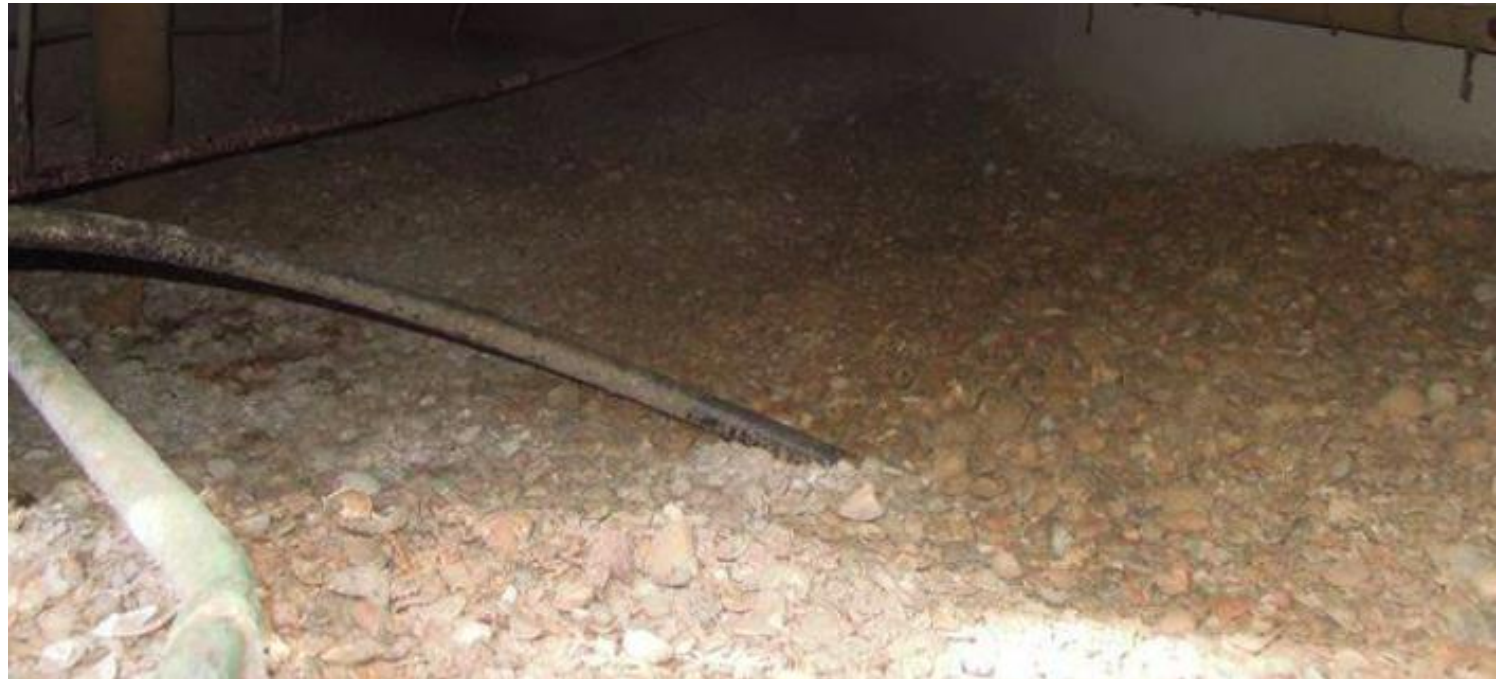
Droge en warme kruipruimte door schelpisolatie
